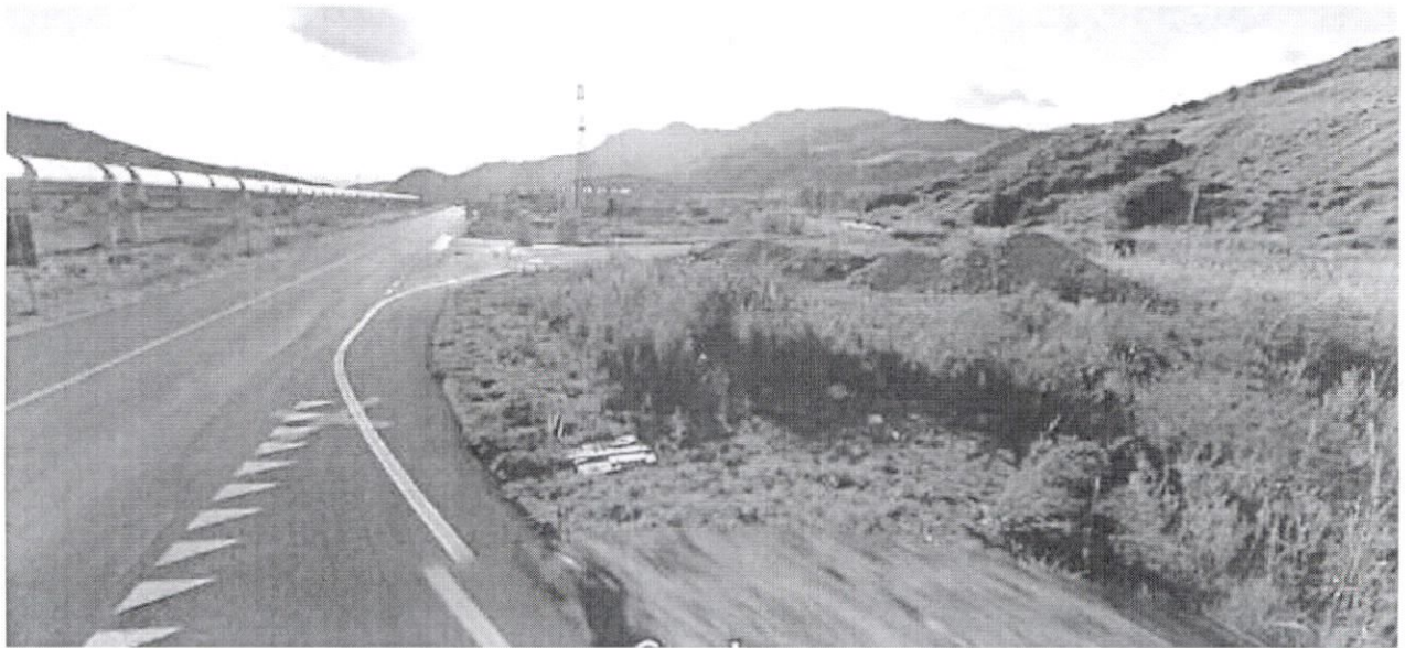
Foto n. 6 Strada comunale zona industriale.
