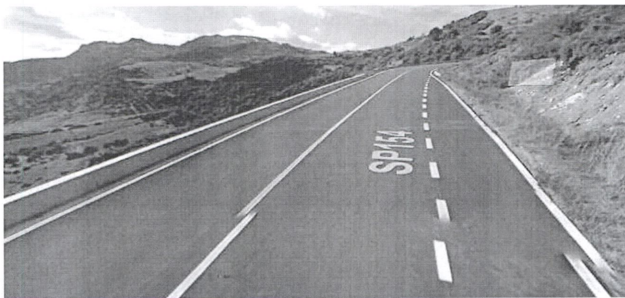
Foto n.5 Strada Colobraro-Sinnica per posa condotta acquedotto zona industriale.
